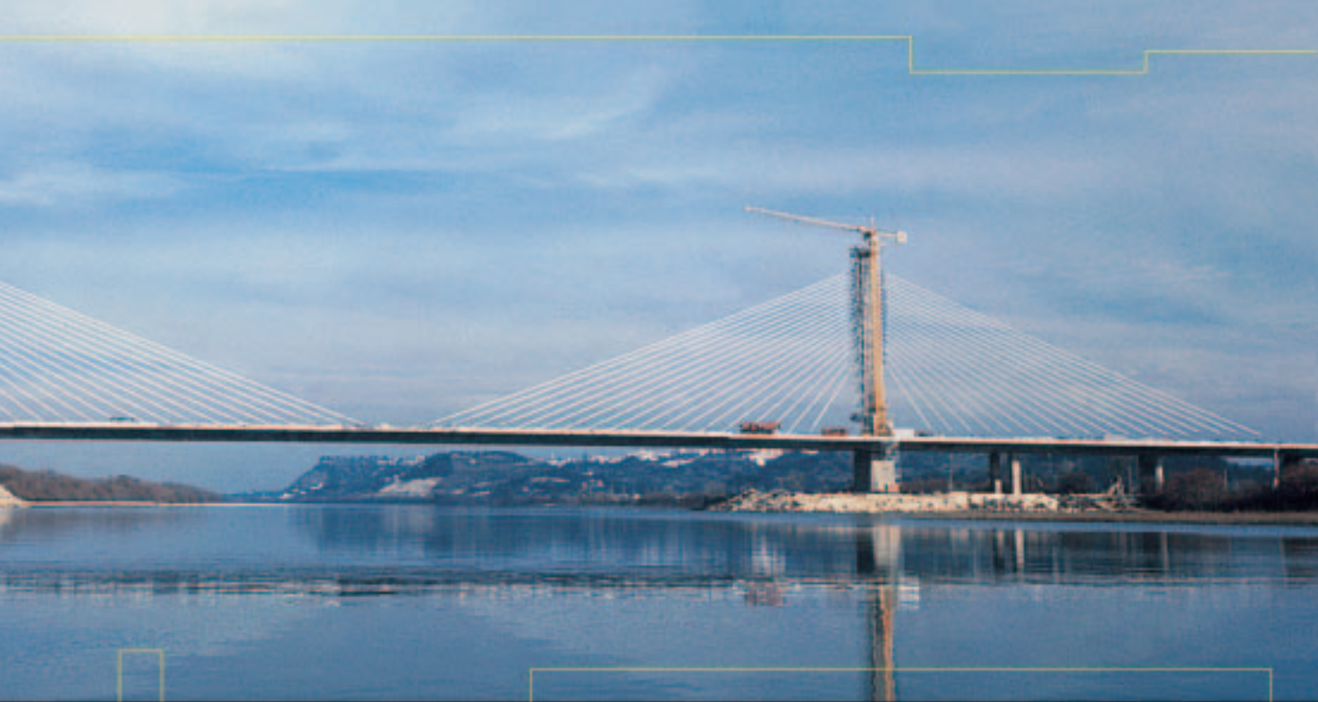
PONTE SALGUEIRO MAIA - Nova ponte sobre o rio Tejo em Santarém
